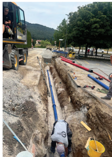
• Obnova vodovoda pri OŠ Stari trg
