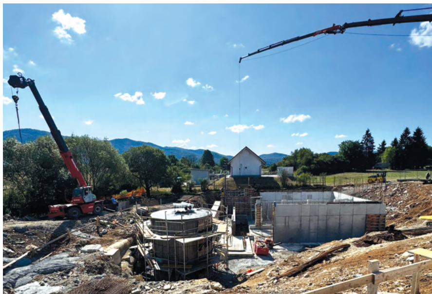
• Gradnja čistilne naprave
